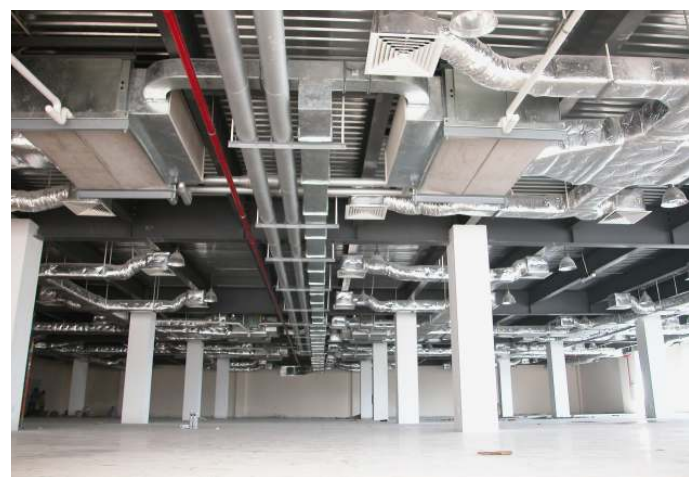
THI CÔNG CÁC CÔNG TRÌNH NỘI THẤT VÀ ME
